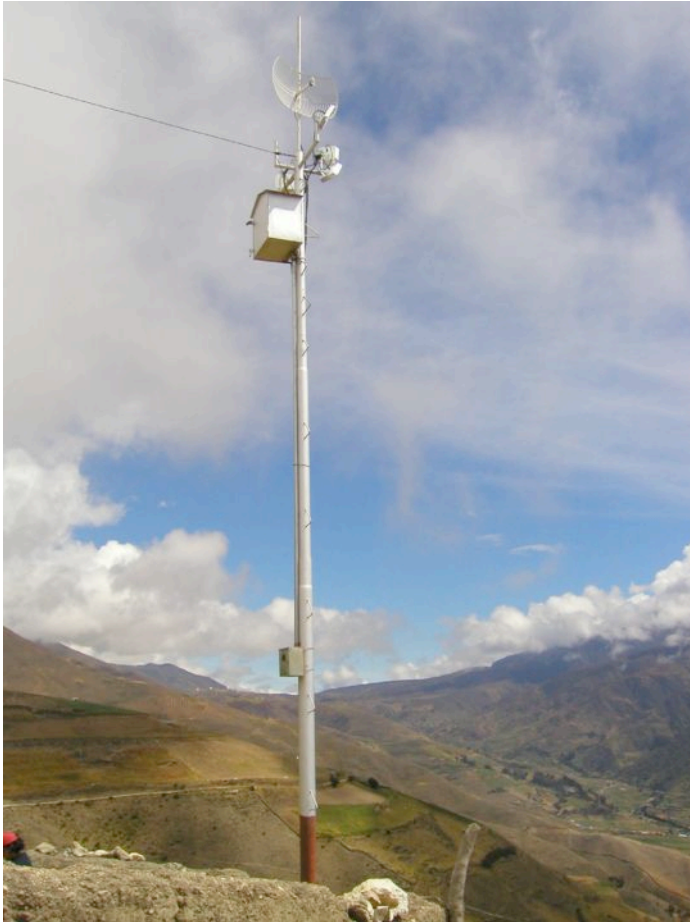
Figura 7.3: Una torre autosoportada sencilla.
